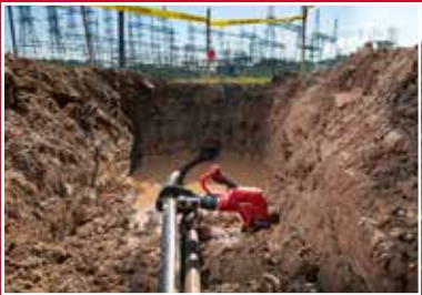
Otwarta konstrukcja szczęk ułatwia podejście do przewodu
